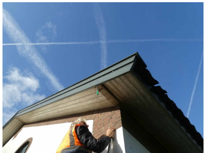
Figuur 12 Geen enkele ruimte dakoverstek
