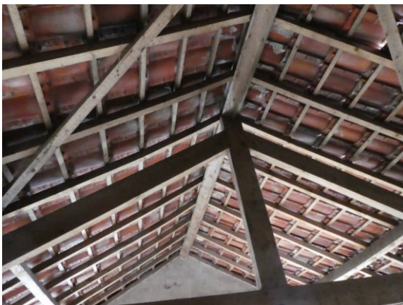
Figuur 10 Dakconstructie binnenzijde
