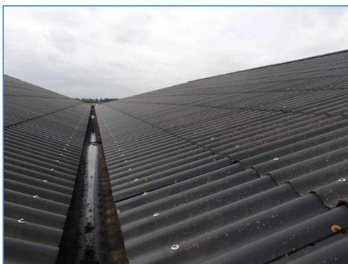
Niet asbesthoudend dak Hal 8
