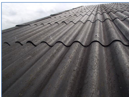
Niet asbesthoudend dak Hal 6
