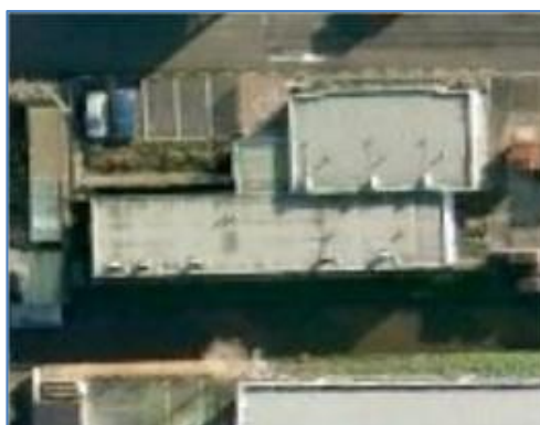
Bovenaanzicht Kantoor (geen asbest)
