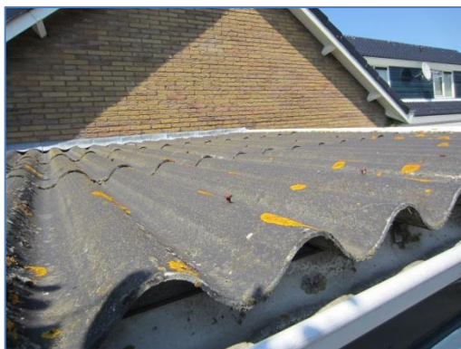
Asbest dak - Berging (Barwoutswaarder 87A)
