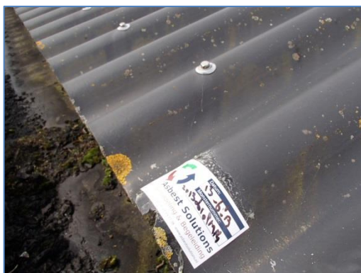
Niet asbesthoudend dak Hal 7
