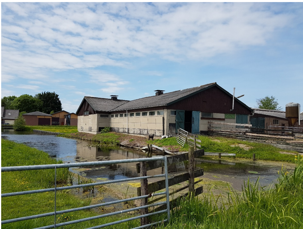
Figuur 4 Zij en achteraanzicht van de schuur aangrenzend aan het woonhuis. De veensloot op de voorgrond wordt doorgetrokken.
