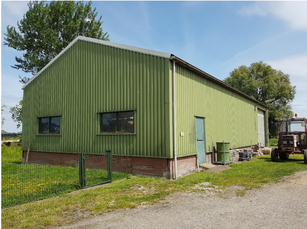
Figuur 3 Schuur aan de noordkant van de planlocatie. Links van de schuur bevindt zich een geitenweide. De schuur heeft geen potentie als rust-, broed en/of verblijfplaats voor huismuis en vleermuis.
