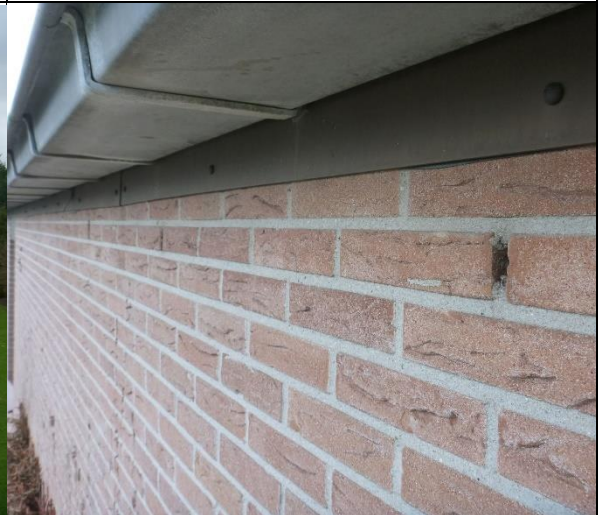
Muur van het woonhuis met open stootvoeg
