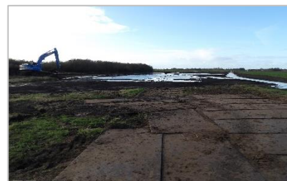
Foto 13: Voor transport wordt een platenbaan aangelegd.
