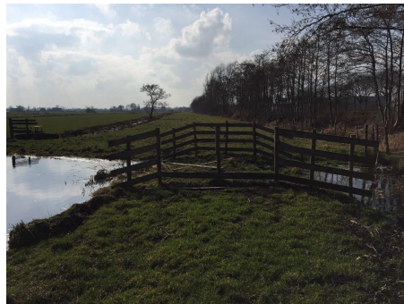
meetpunt Dam 5 met plastic damwand 8491184
