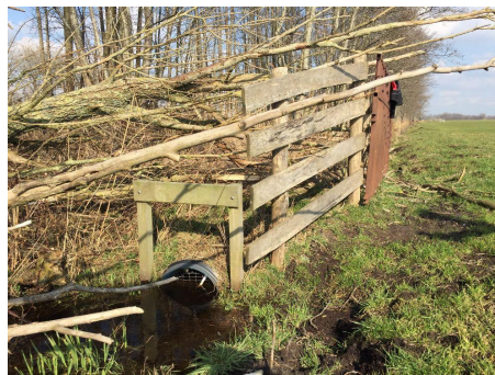
meetpunt Dam 4 met duiker 8491183
