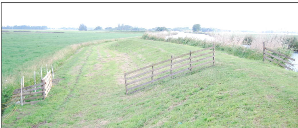
Afbeelding 6: Foto van de dijk en het noordelijk deel van het perceel. Kijkrichting is het noorden.
