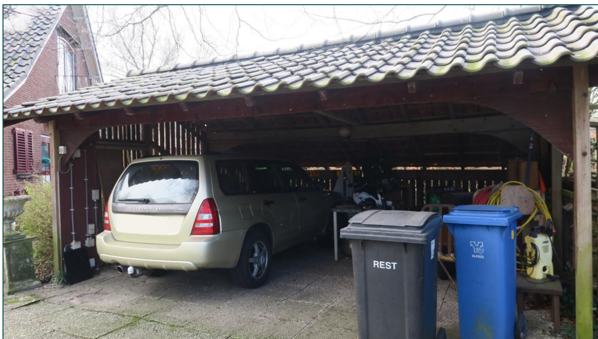
Figuur 3 De carport (3) is opgetrokken uit houten schroten en een pannendak zonder dakbeschot.
