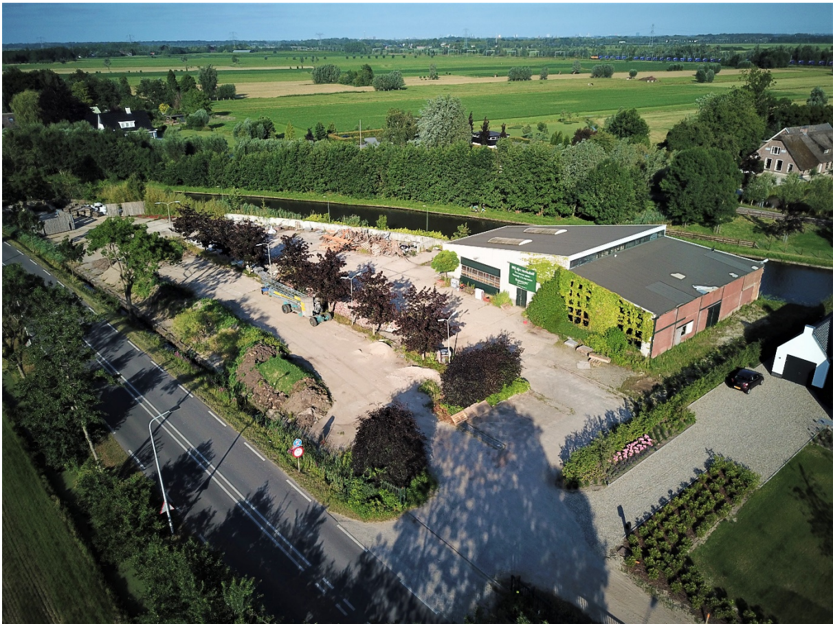
Afbeelding 2.1: huidige situatie plangebied, met rechts het hoveniersbedrijf en daarnaast één van de recent gebouwde vrijstaande woningen.
