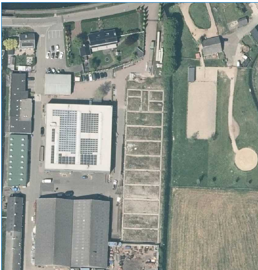
Het plangebied, de aangebracht fundering is hierop zichtbaar (bron: ruimtelijkeplannen.nl)
