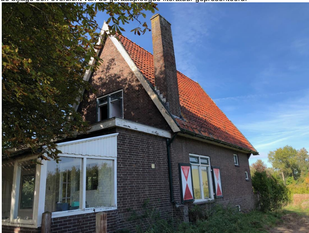
Gedeeltelijk aanzicht te slopen woning in het plangebied.
