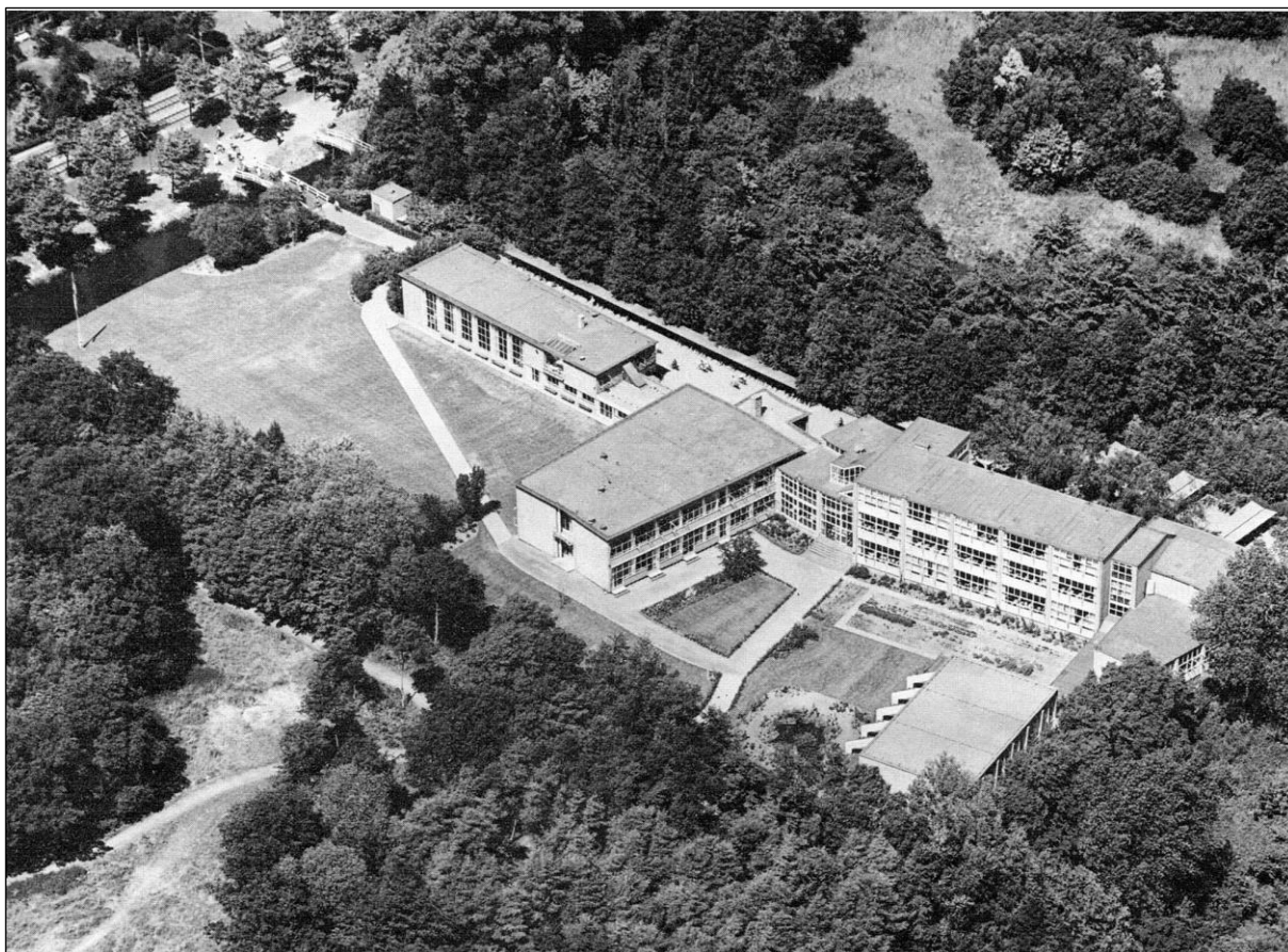
Figuur 16. Het Rijnlands Lyceum met links de oudste bouwphase van 1938-1940 en rechts en rechtsonder de uitbreiding van 1950-1952, tegenwoordig aangeduid als de B-vleugel. Het perceel wordt begrensd door restanten van het Springerpark (boven) en het Petzoldpark (onder). Linksboven de Zijlwetering en de Backershagenlaan.
