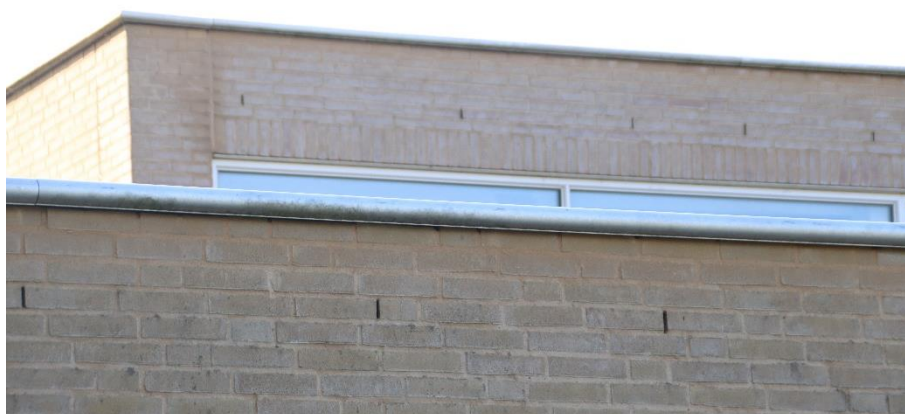
Figuur 5.1. De openstootvoegen in het pand waaraan de aanbouw komt.
