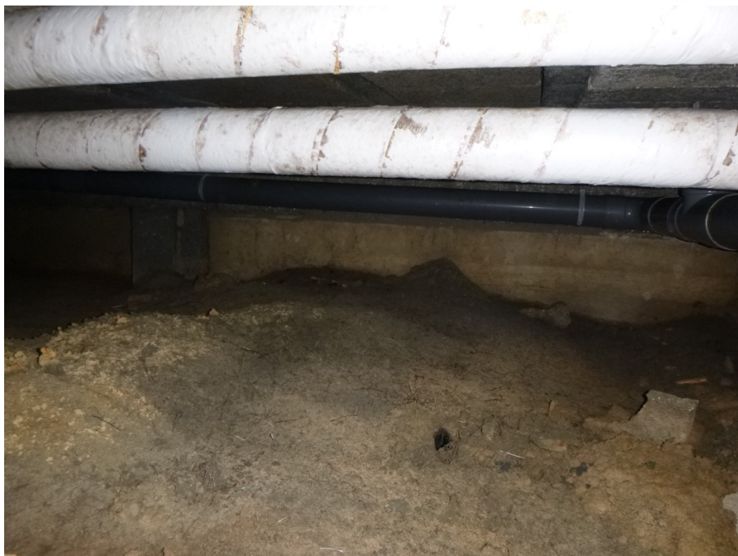
Foto 3: kruipruimte onder het pand.
