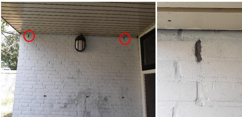
Figuur 4 De enkele stootvoegen die in de bebouwing aanwezig zijn, zijn afgedicht.
