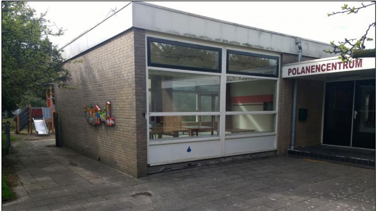
figuur 2. Huidige situatie (bron: wassenaarder.nl)
