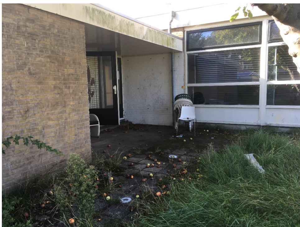
Foto 2: Zicht vanuit noordwestzijde op onderzoekslocatie.
