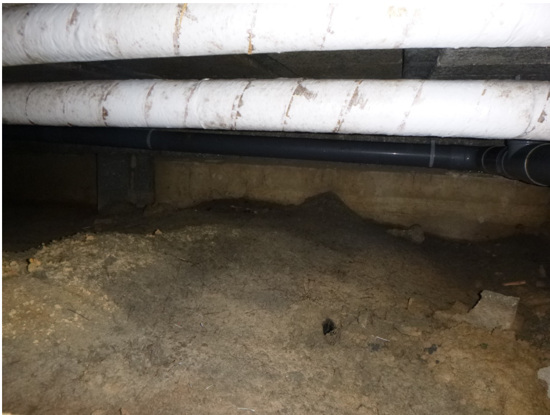
Foto 3: kruipruimte onder het pand.
