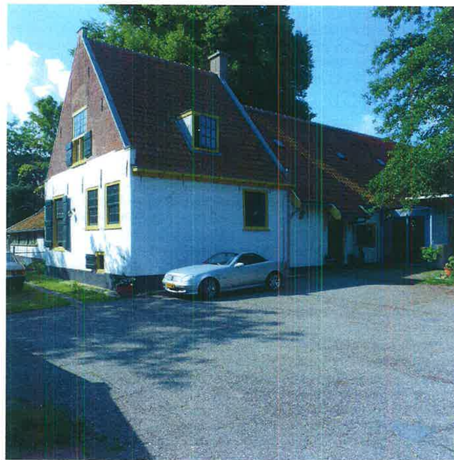
afbeelding 52. Zicht op het woonhuisgedeelte van de boerderij "Welgelegen", gezien richting het zuiden. Foto: Vlaardingerbroek & Wevers, juli 2011.
