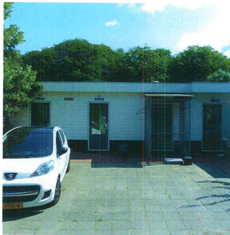
afbeelding 69. Zicht op de westgevel van het kattenhuis, gezien richting het oosten. Foto: Vlaardingerbroek & Wevers, juli 2011.
