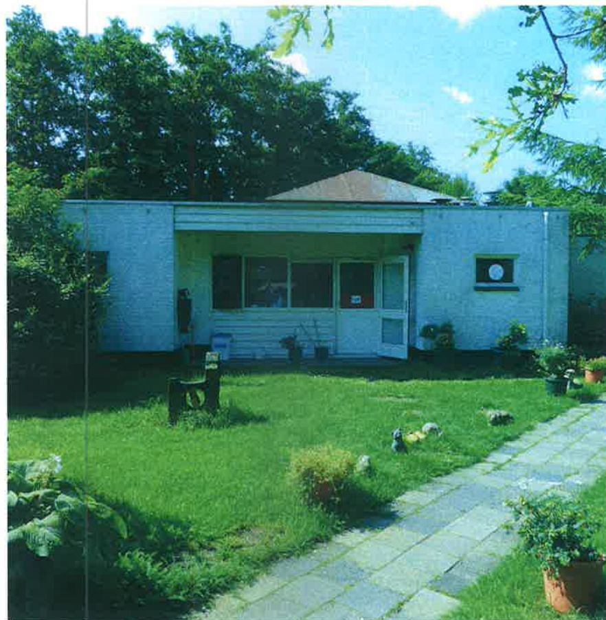
afbeelding 67. Zicht op de noordgevel van de seniorenclub, gezien richting het zuiden. Foto: Vlaardingerbroek & Wevers, juli 2011.
