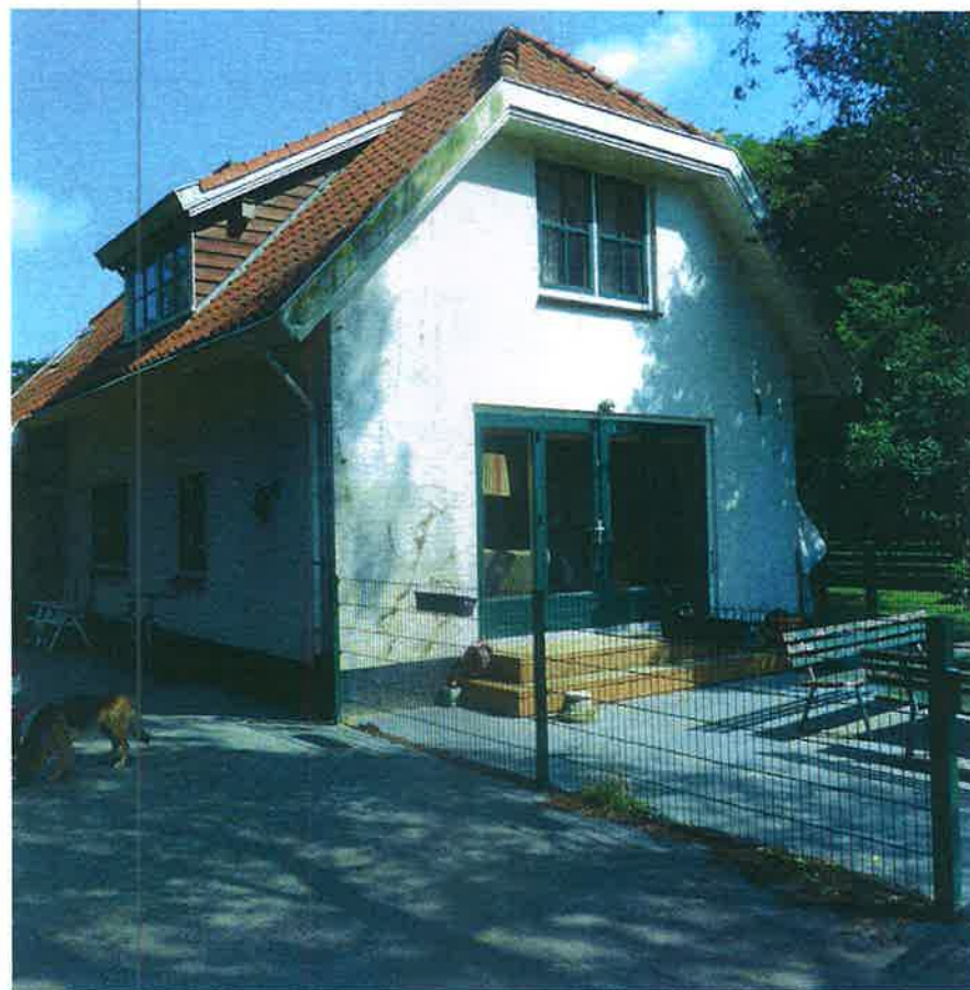
afbeelding 49. Overzicht van de voorgevel van de beheerderswoning, gezien richting het noordoosten. Foto: Vlaardingerbroek & Wevers, juli 2011.
