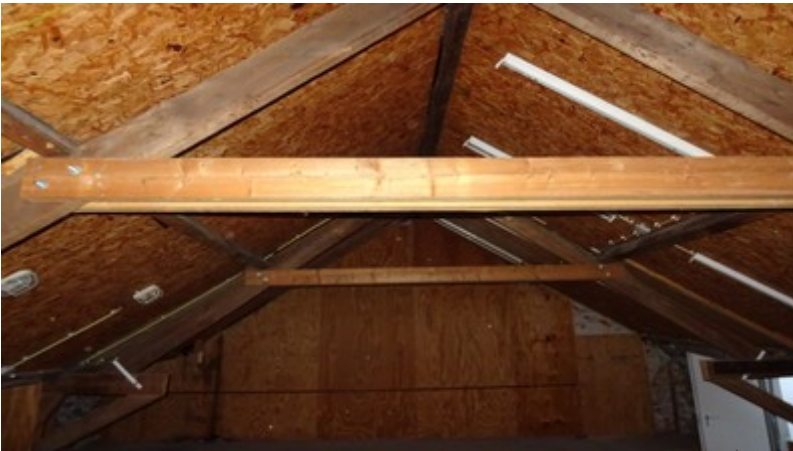
Binnenzijde van de dakopbouw. Foto: K. van Veen | Ecoresult B.V.
