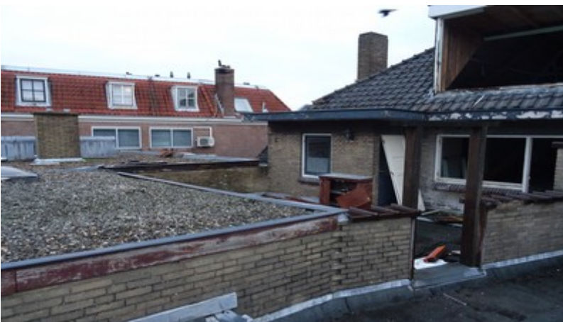
Bebouwing direct grenzend aan het plangebied (rechts) de grens van het plangebied ligt tegen de gevel aan de rechter zijde. Foto: K. van Veen | Ecoresult B.V.
