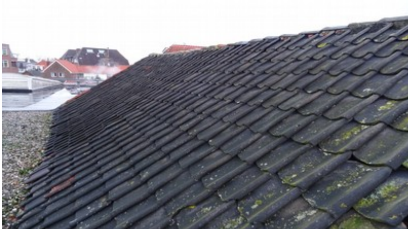
Dakopbouw met dakpannen. Foto: K. van Veen | Ecoresult B.V.
