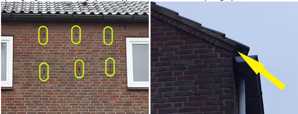
Fig. 6: links een voorbeeld van geschikte open stootvoegen
