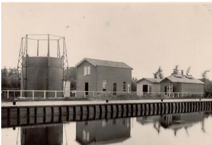
De eerste gasholder aan de Haven bij de Oostdorperweg, ca. 1915 (Bron: GAW 05941)
