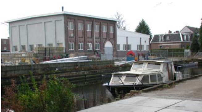
Gemeentewerf/Havenstraat gasontvangst- en reduceerstation
