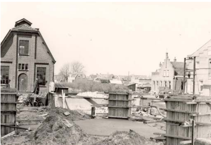
Vorbereidingen voor de bouw van de bolgashouder op de gemeentewerf aan de Havenstraat, 1956 (Bron: GAW 05863)
