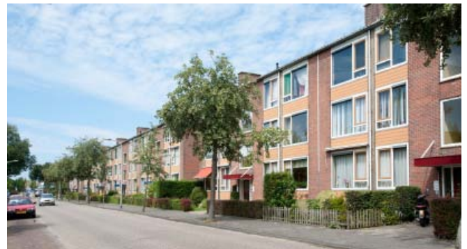
Hofcampweg 130-248: naoorlogse strokenbouw van drie bouwlagen met kap.
