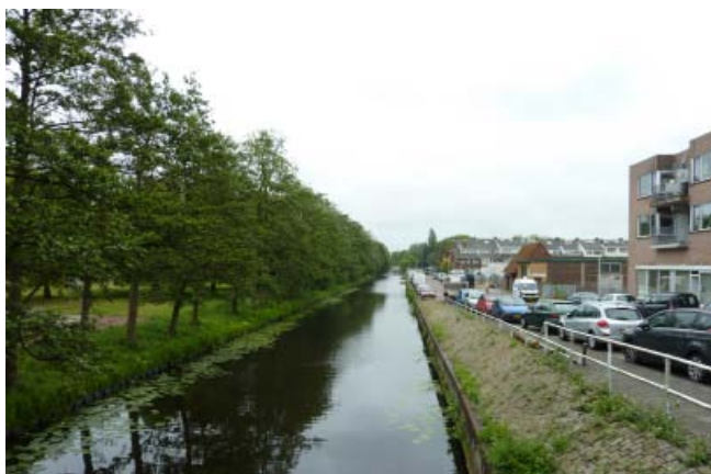
Zijlwatering, gezien in zuidelijke richting.
