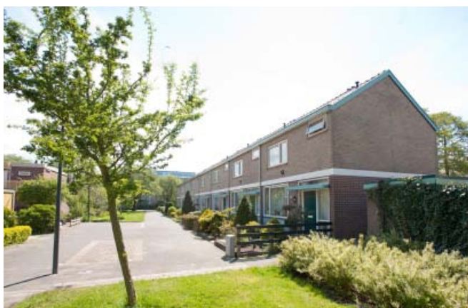
Van Houtenweg in Hofcamp, naoorlogse woningen in twee bouwlagen en zadeldak evenwijdig aan de straat en voorzien van voortuinen.
