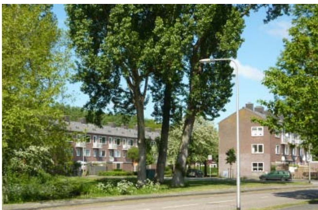
Fagelstraat: woningbouw uit de jaren zestig: strokenbouw bestaande uit drie bouwlagen met zadeldak in een groene setting.
