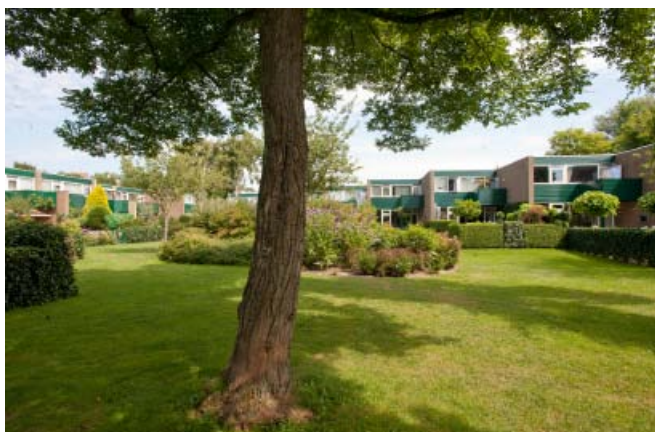
Woningbouwproject van de Wassenaarse Bouwstichting uit 1975 aan de Prof. Molenaarlaan: laagbouw in een groene setting.
