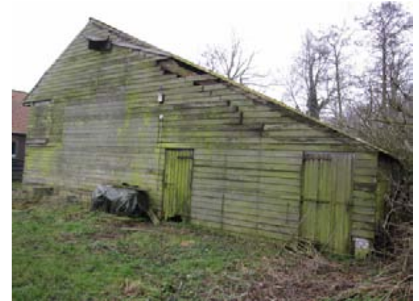
De halfopen schuur voor opslag van materieel en goederen.
