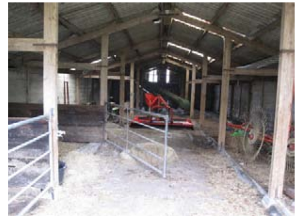
Interieur van de betonnen schuur.
