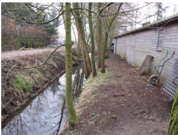
Afwateringssloot tussen de insteekweg naar nummers 20-22 en het erf van de manege, vermoedelijk reeds in 1822 aanwezig.
