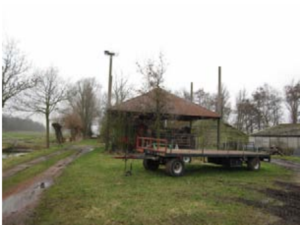
Kapberg met vier roeden, oorspronkelijk voor de opslag van hooi.
