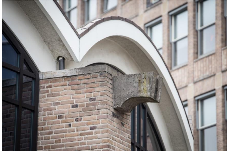
Detail van het exterieur van de rotonde.
