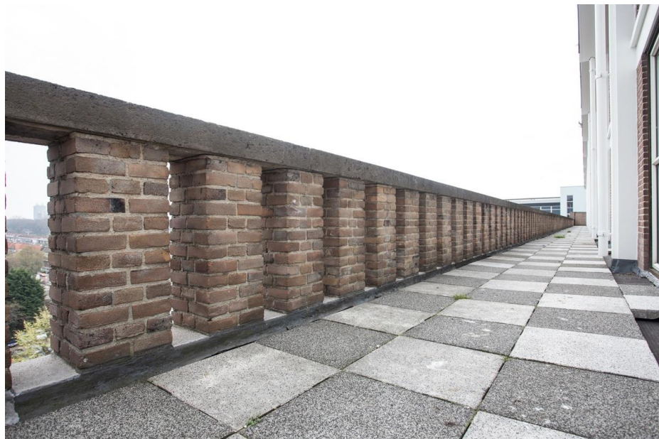
De balustrade op de dakrand.
