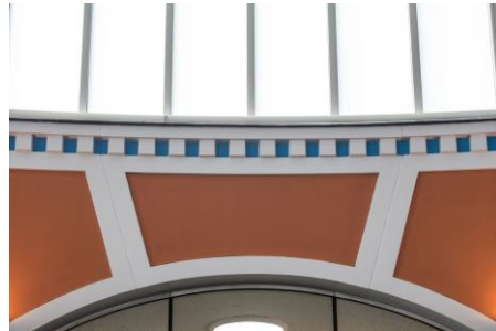
Aansluiting van de kolommen die met profielstukken zijn afgetimmerd op de ringbalk. Rechts de elementen die door de architect timpanen werden genoemd.
