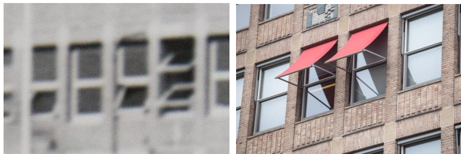
Vensters uit de bouwtijd links op een foto uit de jaren zestig, rechts de huidige vensters en toegevoegde buitenzonwering. De vensters uit de bouwtijd werden geleverd door de firma Radeffa uit Apeldoorn (faillissement in de jaren tachtig).
