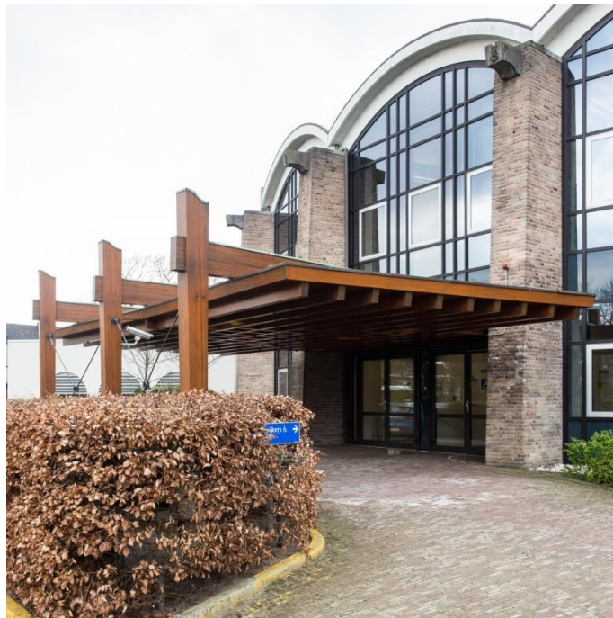
Luifel bij de personeelsingang (begane grond).
