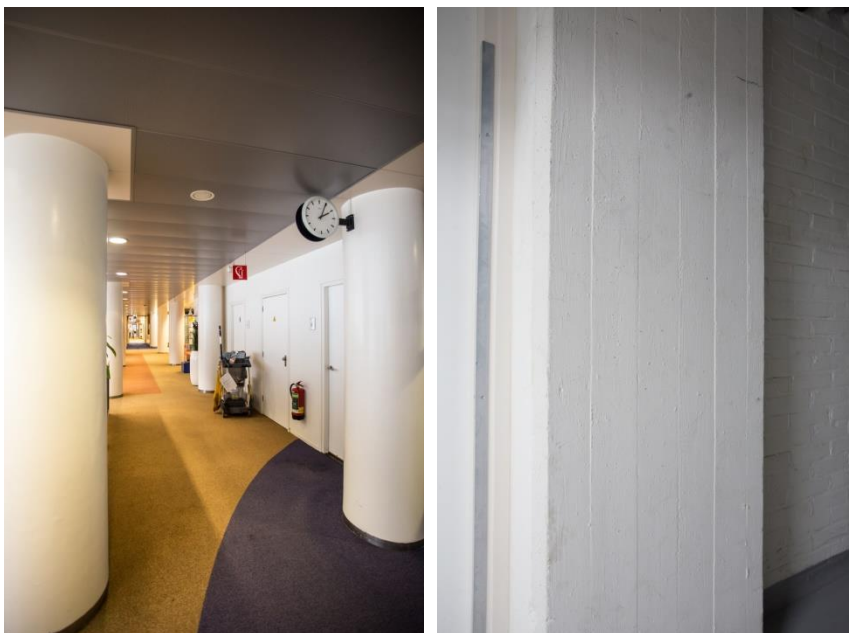
Kolommen op de verdiepingen staan van oudsher vrij van de vrijdragende gangwanden. Dit met uitzondering van de kelder, waar gangmuren tussen de kolommen (bekistingssporen) zijn geplaatst.
