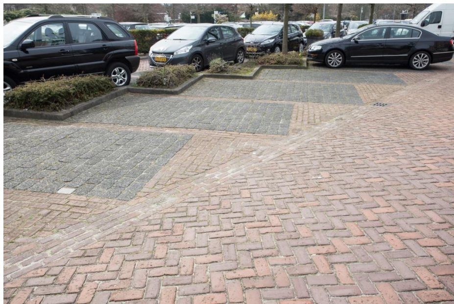
Van oudsher schuine parkeervakken (evenwijdige vakken daarachter dus secundair), klinkerbestrating in keper- en halfsteensverband én koperslakkeien in halfsteens verband.
