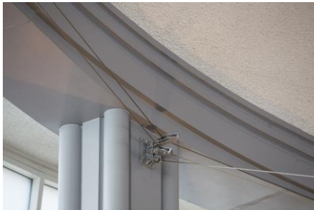
Aansluiting van de kolommen die met profielstukken zijn afgetimmerd op de ringbalk. Rechts de elementen die door de architect timpanen werden genoemd.
