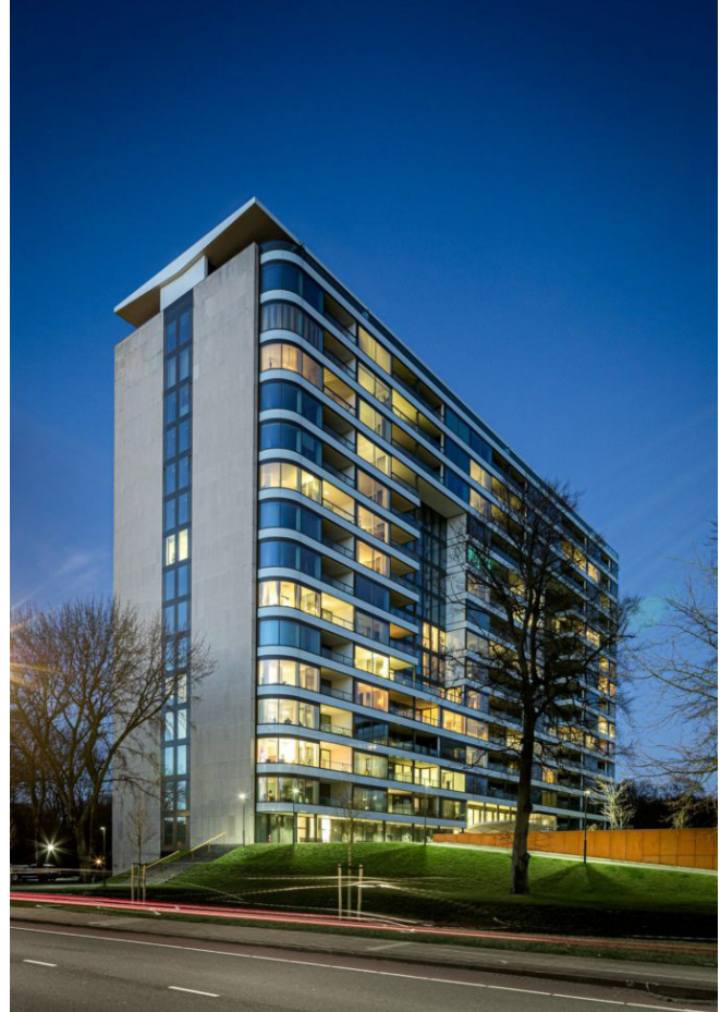
Haagse hoogbouw: transformatie Shell gebouw
