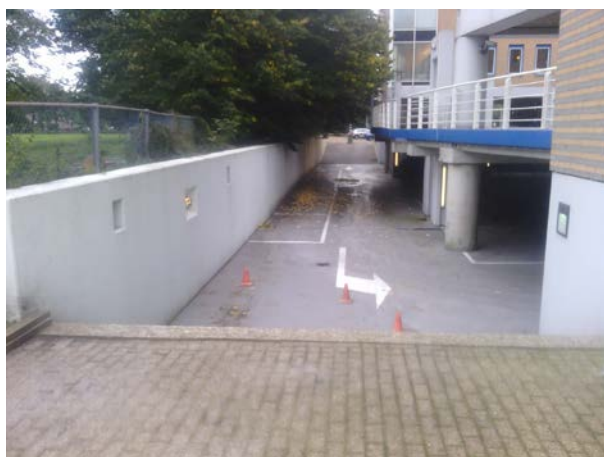
Foto 1: ter plaatse van Boring 07 (1)
