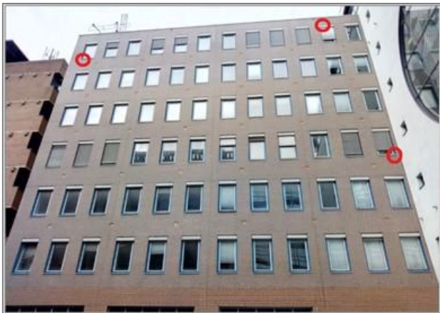
Afbeelding 2.5 | zomerverblijfplaatsen Z8-Z10 op de zuidgevel van gebouw D.
