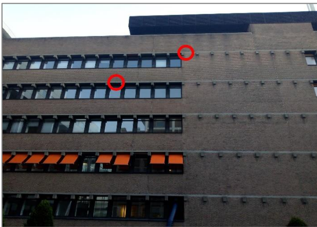
Afbeelding 2.3 | Zomerverblijfplaatsen Z4 en Z5 op de zuidgevel van gebouw B.
