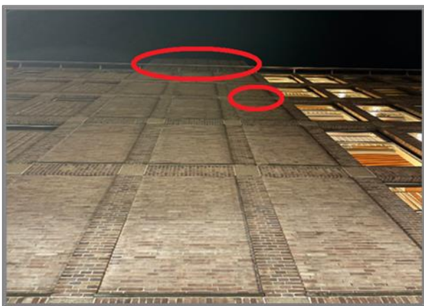
Afbeelding 2.13 | Winterverblijfplaatsen W1 en W2 op de noordgevel van gebouw A.
