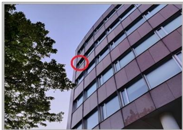
Afbeelding 2.12 | Zomerverblijfplaats Z30 op de oostgevel van gebouw H.
