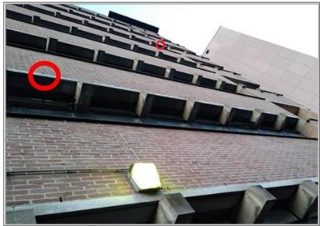
Afbeelding 2.2 | Zomerverblijfplaatsen Z2 en Z3 op de noordgevel van gebouw B.
