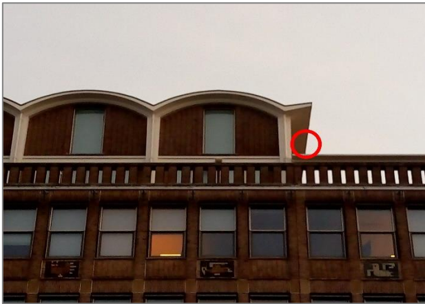
Afbeelding 2.1 | Zomerverblijfplaats Z1 op gebouw A.
