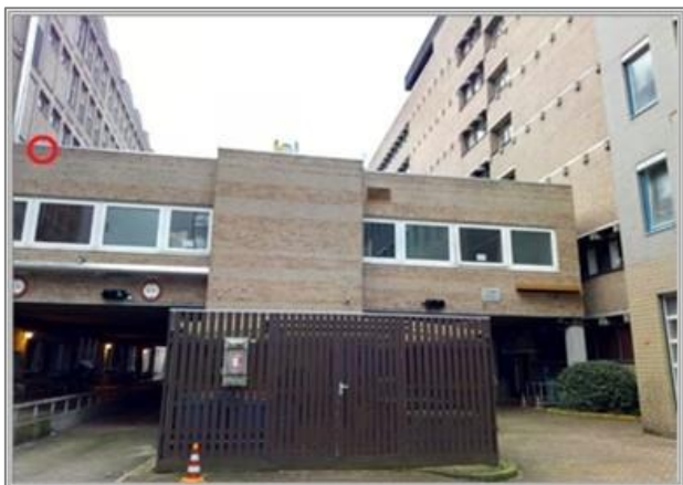
Afbeelding 2.11 | Zomerverblijfplaats Z29 op de oostgevel van gebouw G.
