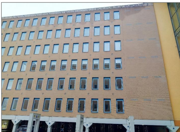
Afbeelding 1.5 | Gebouw E noordzijde vanaf parkeerdak.
