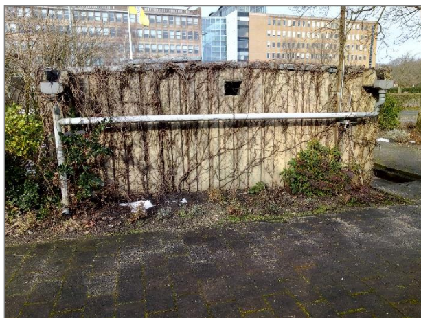
Afbeelding 4.13 | Pompkamer met ten minste drie ruime openingen en gleuven langs de dakranden.
