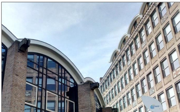
Afbeelding 4.16 | Bij gebouw R zitten enkele openingen waar de regenpijp het dak in gaat, geen sporen of uitwerpselen.
