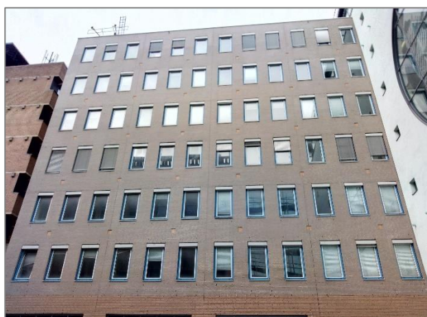
Afbeelding 1.4 | Gebouw D zuidzijde. (Rechts gebouw C, links gebouw B)
