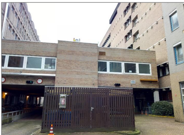
Afbeelding 1.7 | Gebouw G oostzijde. (Rechts gebouw D en B, links gebouw A.)
