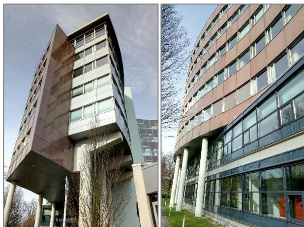
Afbeelding 1.8 | Gebouw H: links zuidzijde en rechts westzijde.
