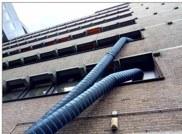
Afbeelding 1.2 | Gebouw B zuidzijde. (Links oostzijde gebouw H.)
