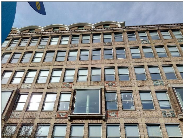
Afbeelding 4.1 | Dilatatievoeg (rechts van midden) en rolgordijnen, gebouw A.
