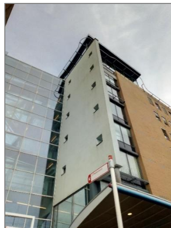
Afbeelding 4.4 | Gebouw C nabij ingang (lichtgroen) met ruimte onder kozijnen.
