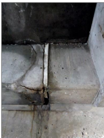
Afbeelding 4.6 | Openingen in de parkeergarage onder gebouw E en F.
