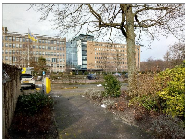
Afbeelding 1.10 | Parkeerterrein met links in beeld de pompkamer. (Achtergrond gebouw A en E)
