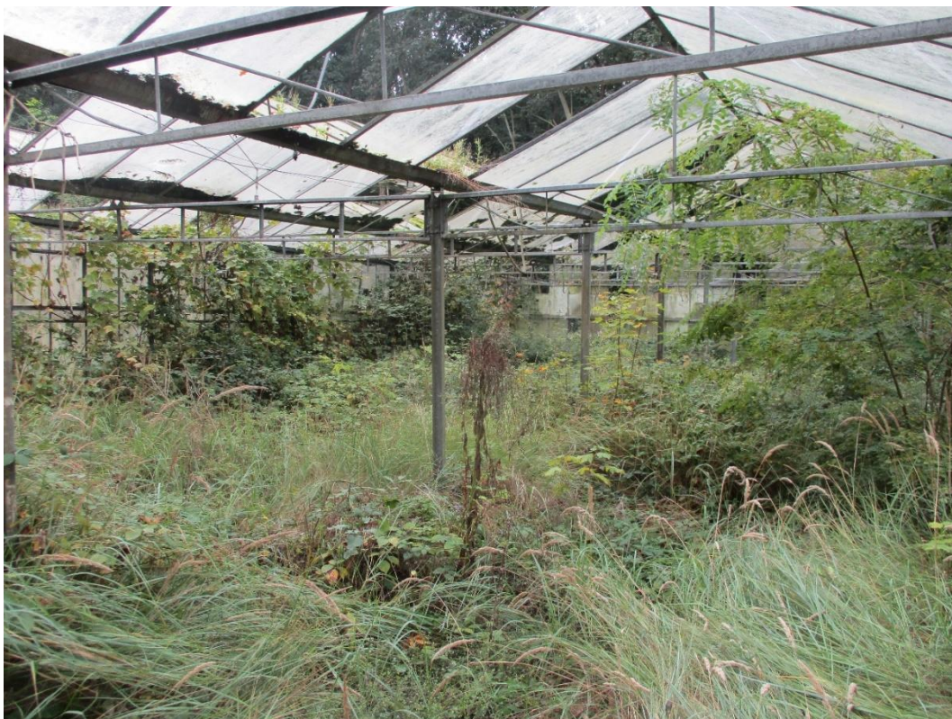
Figuur 3 Het vervallen kassencomplex is overwoerd met grassen en bramen.
