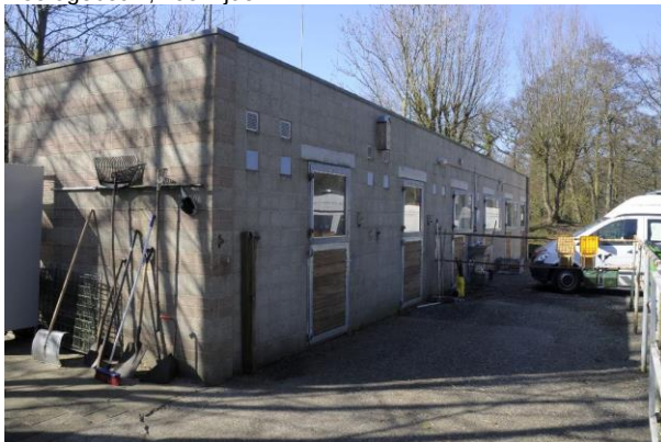
Aanbouw boven bunker
