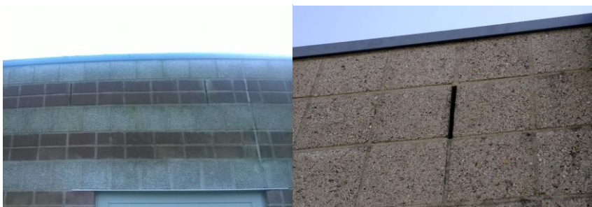
Figuur 3.4.2, smalle spouwgoten in het hoofdgebouw
