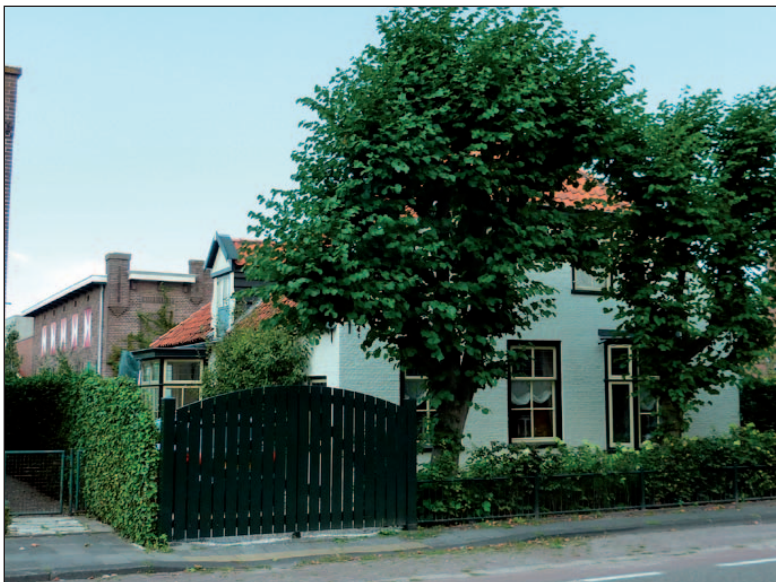
54 In 1923 liet de weduwe P. Straathof naar ontwerp van architect A. Bontenbal een bollenschuur achter het huis bouwen, foto 2010.
