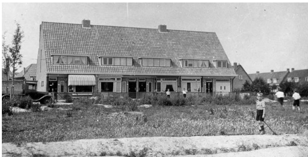
Hallekensstraat 2-14: door bouwhoogte, kapvorm, nokrichting etc. passend bij het karakter van Oostdorp, foto 1931 (GAW 00233)
