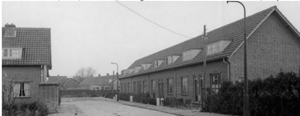
Hallekensstraat 70-84, 1950 (GAW 00237), woningen uit 1941 van P.W.M. van der Klaauw, complex 10.
