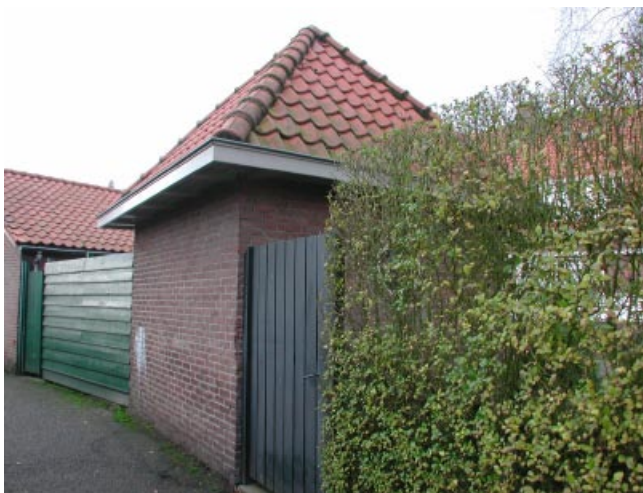
Voorbeeld van een berging, gelegen in de achtertuin van Herman Costerstraat 19 en aldaar een markering voor de toegang tot het achterpad.
