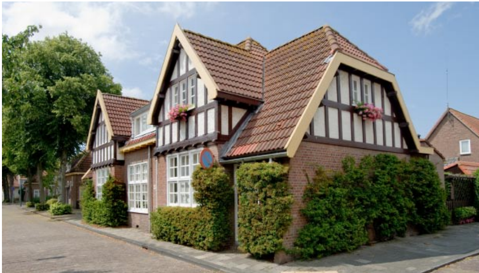
De woningen Hallekensstraat 45-49 van architect Broese van Groenou uit 1913 (complex 1) vallen op door stijlkeuze en rijkdom van materialen en details.
