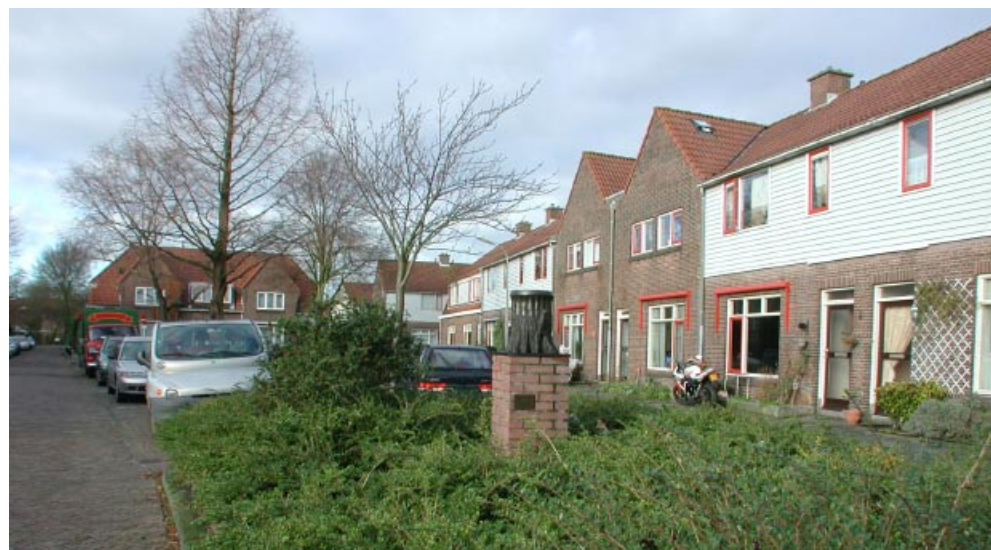
Complex 9: woningen aan de Rozensteinstraat, St.-Willibrordusstraat, Broekweg en Kasstraat van de Woningbouwvereniging St. Willibrordus, uit 1920 van architect H. Groenewegen.
