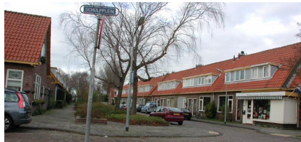
De Bloemluststraat, gezien vanaf het Schulppelein
