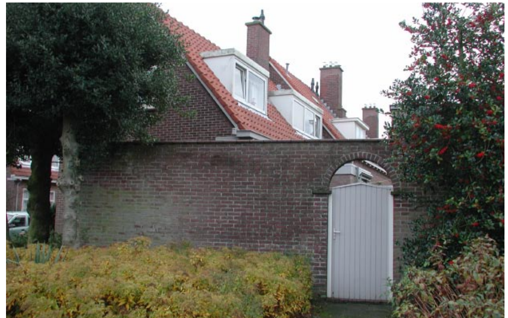
De woning Dr. Leydsstraat 21 is via een gemetseld muurtje met daarin een poortje met de bebouwing aan de Hallekensstraat 16-26 verbonden.
