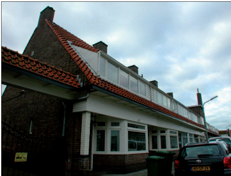
58 In 1933 ontwierp P. van der Klaauw de woningen aan de Dr. Leydstraat 1-7. Hij bouwde in de jaren dertig ook het complex langs de Van Zuylen van Nijeveltstraat 300-378/Dr. Mansvelt-kade 2-20 en de blokken Hallekensstraat 2 - 14/Hallekensstraat 3 - 9a, foto 2009.
