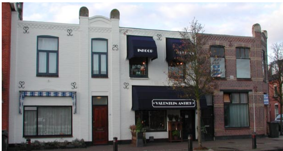
Voorbeeld van de bebouwing aan de Oostdorperweg: nummers 41 tot 45.
