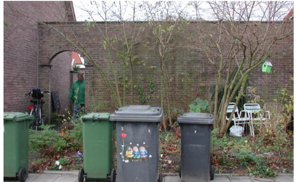
De woningen aan de Chr. de Wetstraat 1-11 zijn via een gemetseld muurtje en een poortje naar het achterpad verbonden met het woningbouwblok aan de Bothastraat.
