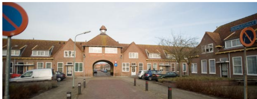
Door de situering van de woningbouwblokken heeft de Bloemluststraat een sterke aswerking in de wijk.
