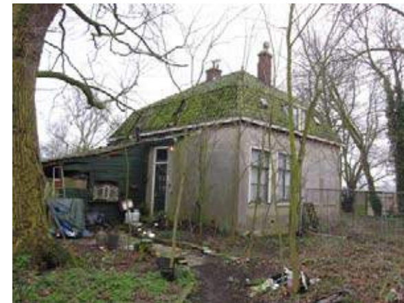
De dubbele woning vanuit het noordwesten, met in de oostgevel één van beide toegangsdeuren.
