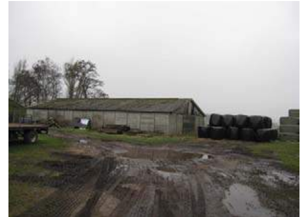
Betonnen systeemboeuwschuur aan de westzijde van het perceel.
