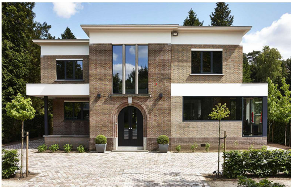
Villa (transformatie) - gerecycleerde baksteen gevels - Vlassak Verhulst
