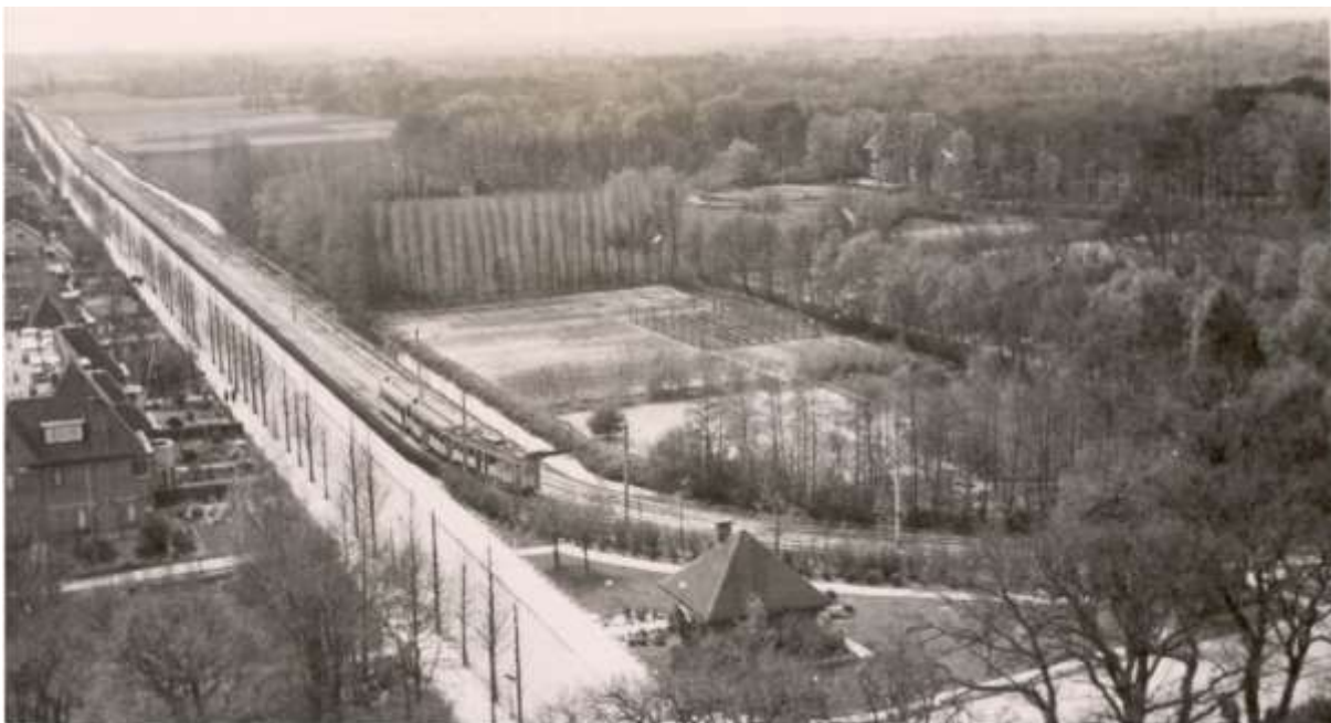
Afb. 2.20 Foto vanaf de toren van de Goede Herderkerk, uit 1941. Links de Wittenburgerweg, met ten westen daarvan de trambaan in een bocht over Stoephout. Naast de trambaan is de oostelijke strook (nu de bosstrook) van Stoephout zichtbaar. Deze strook is ingericht als kwekerij. GAW, id.nr 03042.
