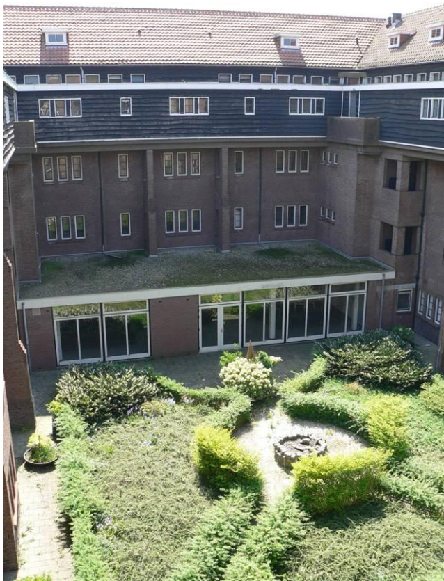
Afb. 3.11: De uitbouw in de binnentuin. (Foto: SB4, 2006)
