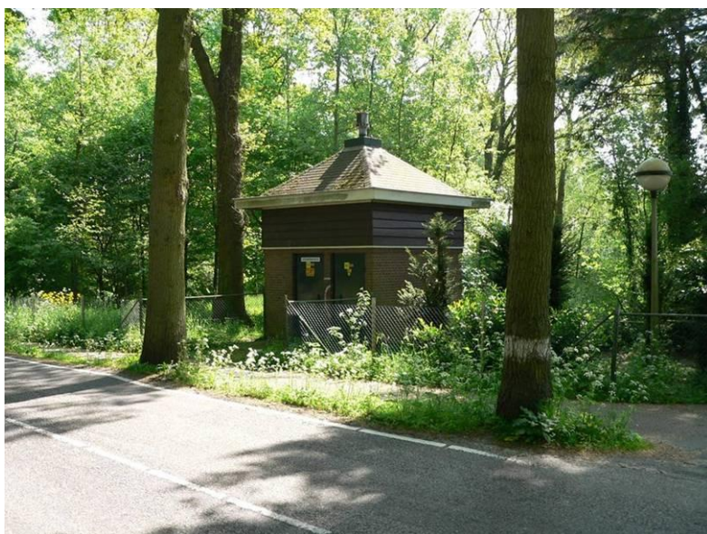
Afb. 4.22: Het trafohuis links van de entree. (Foto: SB4, 2006)
