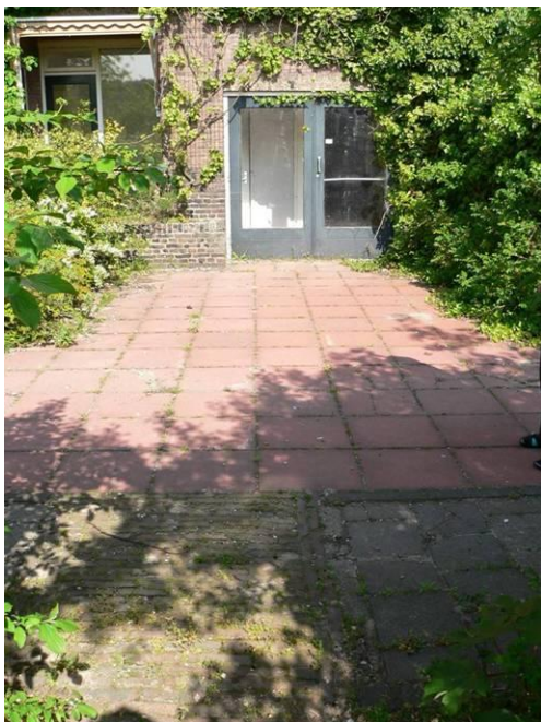
Afb. 4.31: De entree aan de achterzijde. (Foto: SB4, 2006)
