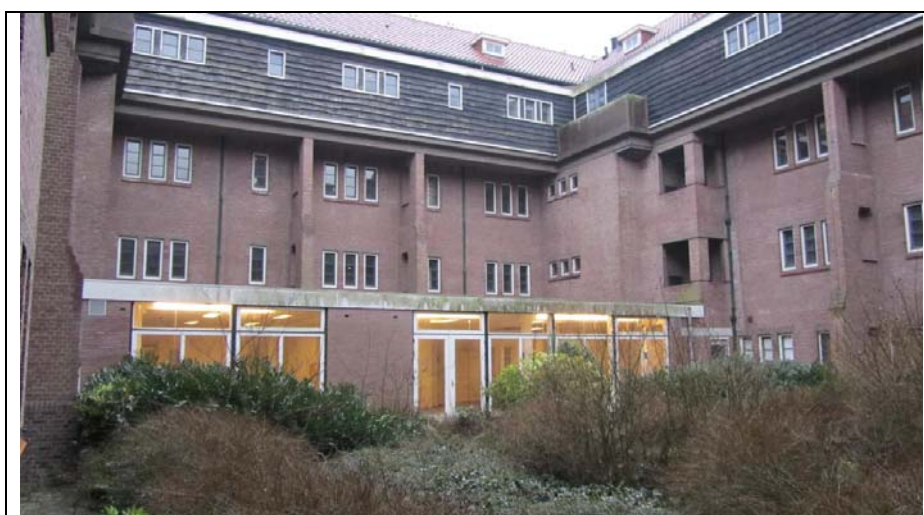
Foto 8: De aanwezige opbouw, welke gesloopt wordt en waar een nieuwe voor in de plaats komt.
