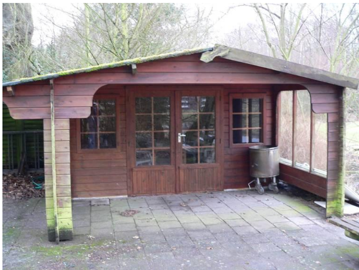
Afb. 4.44: Tuinhuisje. (Foto: SB4, 2006)
