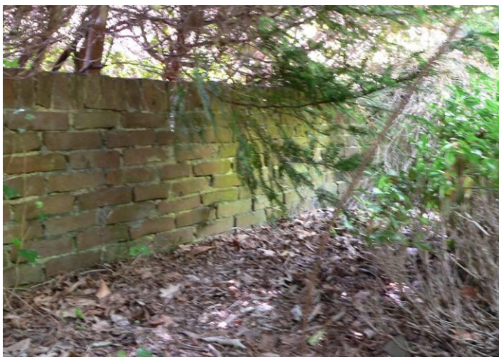
Afb. 4.36: Het bordes tussen de beplanting halverwege het talud van de vijver. (Foto: SB4, 2006)
