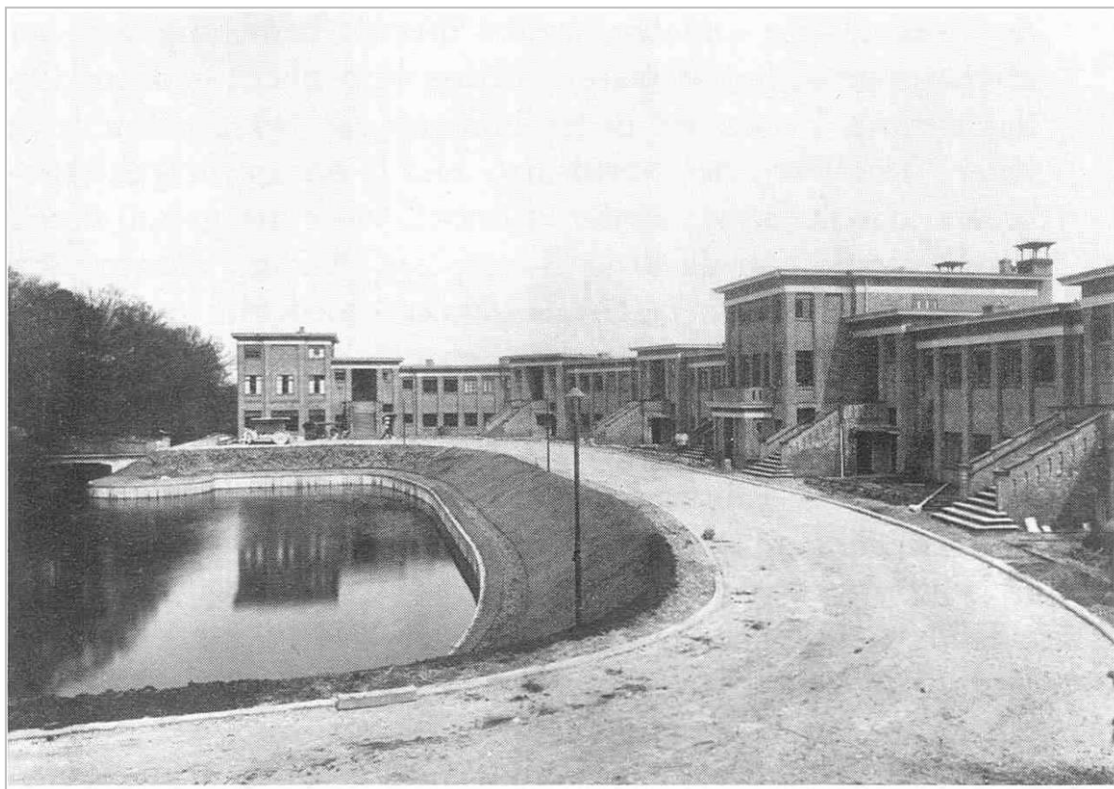
Afb. 3.4: Het WAVO-park in aanbouw. (Herkomst: Van Rooijen, 1988)
