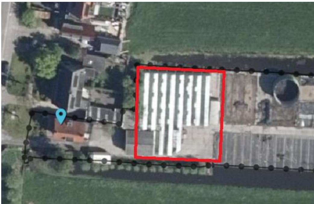
Afbeelding 1 luchtfoto locatie Henegouwerweg 19
