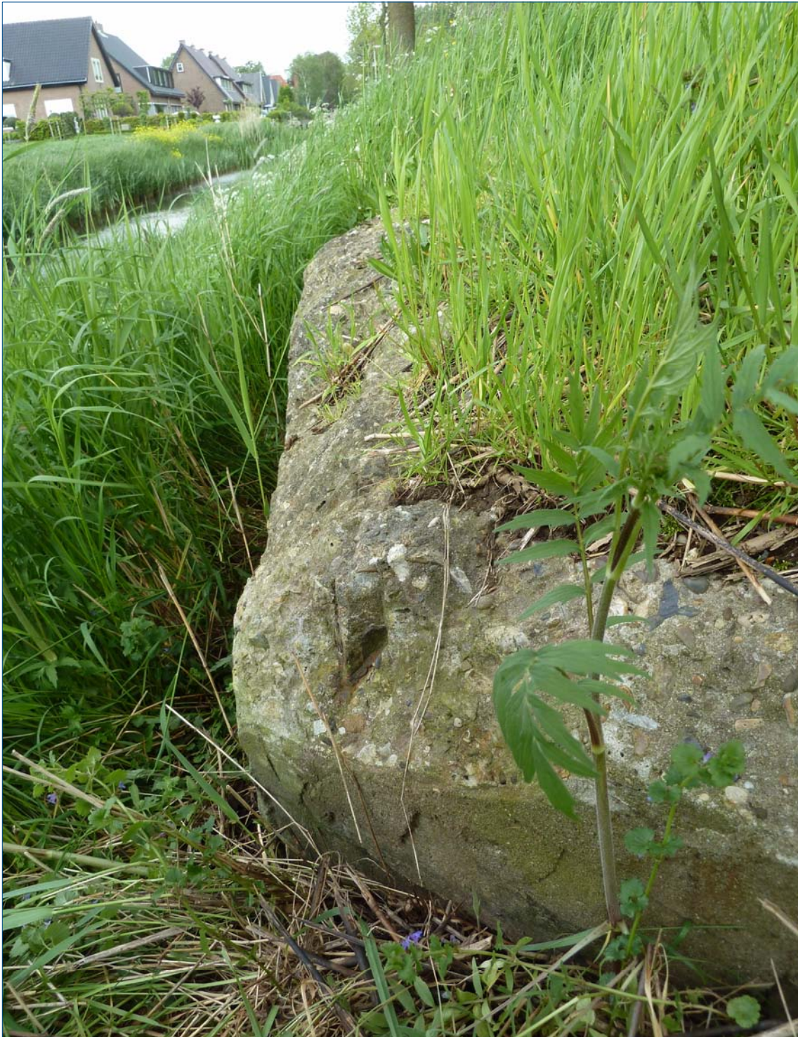
Figuur 5. Het fragment van de tankmuur in de noordelijke berm van de Plasweg, kijkend in oostelijke richting.
