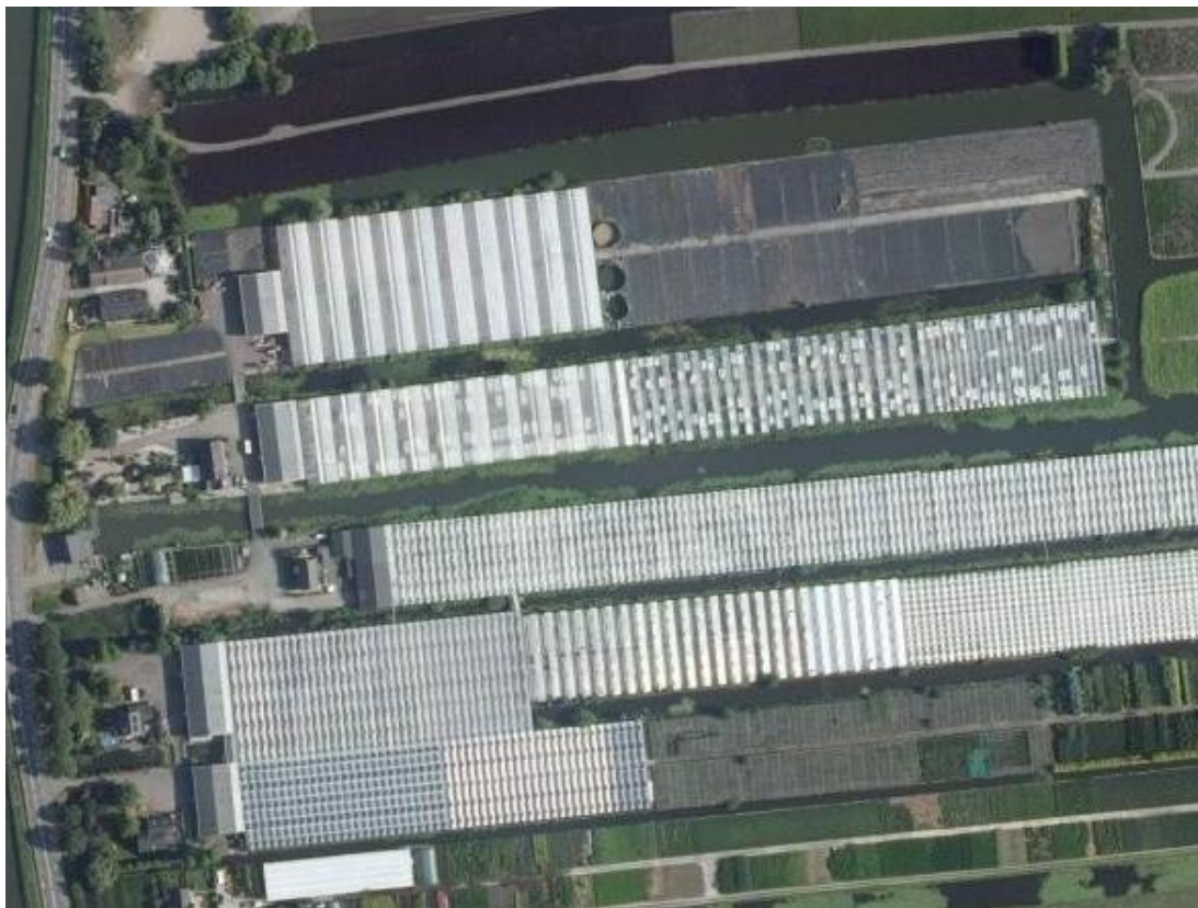
Afbeelding 1 luchtfoto te saneren cluster sierteeltbedrijven langs de Henegouwerweg 96 t/m 102d
