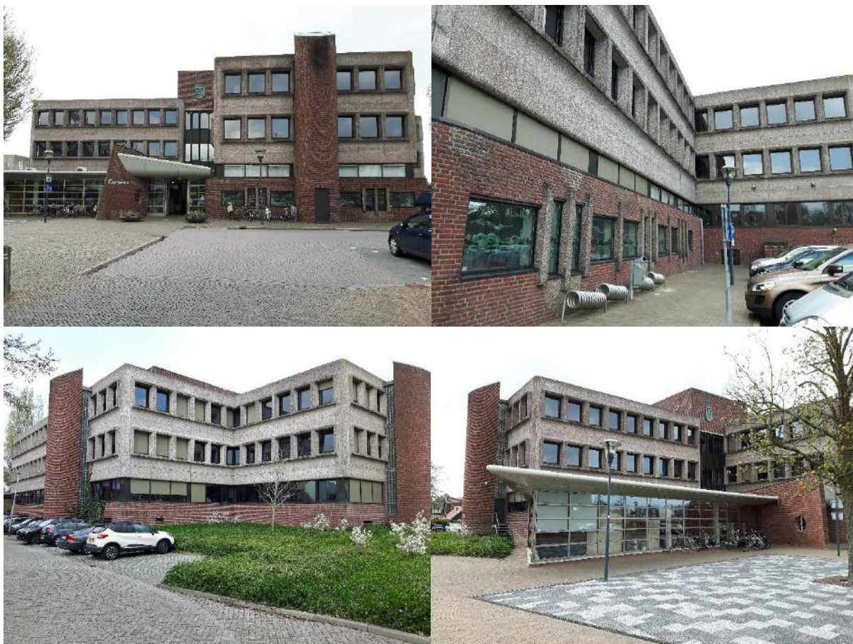
Figuur 2-3. Foto's huidige situatie plangebied.
