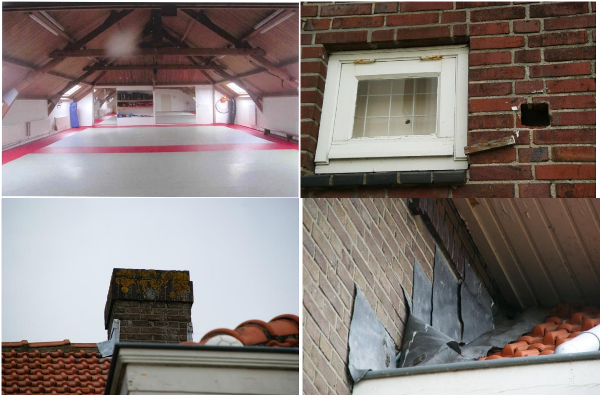
Figuur 4: beeld van binnenruimte op de zolder en mogelijke toegang/verblijfplaatsen voor vleermuizen, via muurgaten, schoorsteen en schuilmogelijkheden achter loodslabben/boorden langs de dakkapellen.
