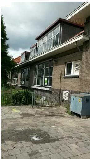
foto 5: Vml ontluchtingspunt en vermoedelijke ligging tank
