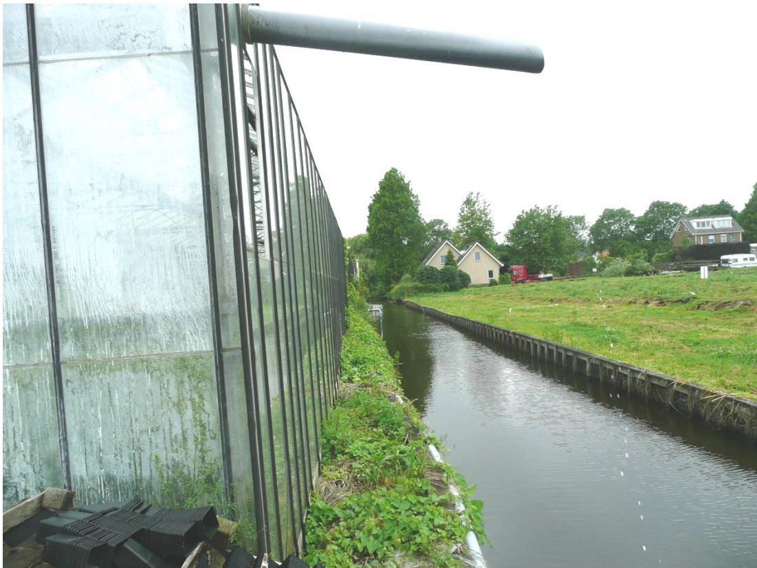
Foto 6. Noordzijde met kas grenzend aan sloot, 13 juni 2016. Glas is met rubberen strips afgedekt. Kas bevat geen asbesthoudende kit (gebouwd na 1995).
