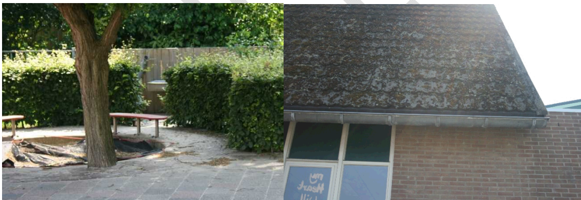
Figuur 3: plein achter te slopen gebouw met zandbak en heggen en dakopbouw met goot
