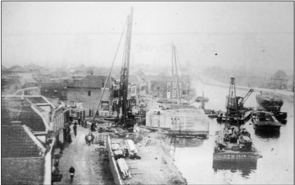
a. Bouw van de fundering van de westelijke heftoren aan de Zuidkade, gezien vanuit het zuiden, 1935, (bron: Versluis 1996).
