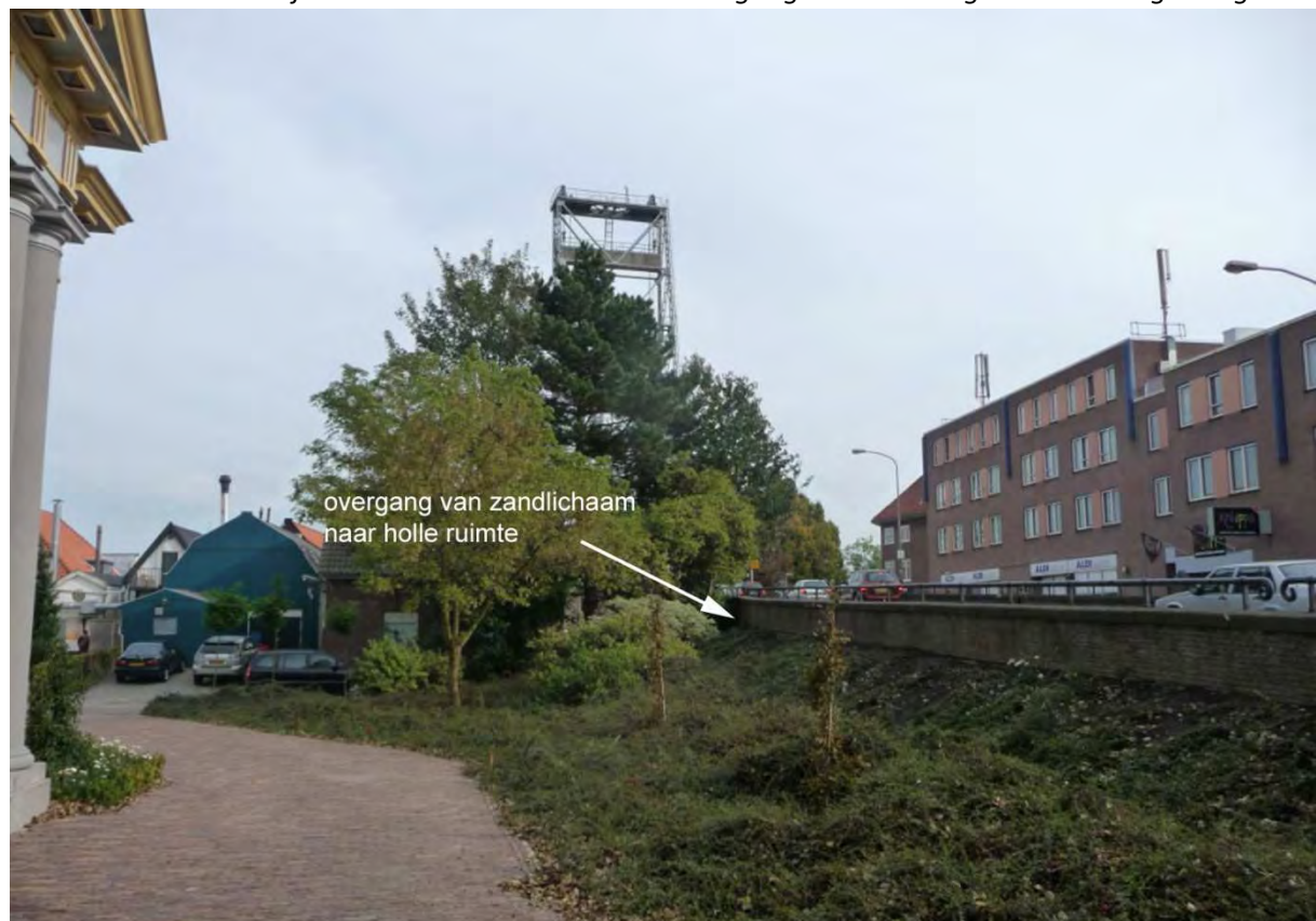
d. Noordkant van de aanbrug met zichtbaar de overgang van het zandlichaam naar de holle ruimte.
