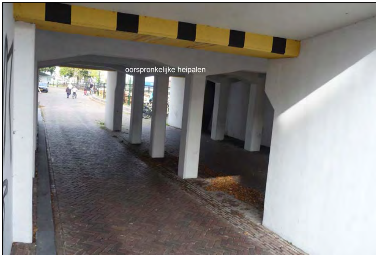
a. Niet-oorspronkelijke onderdoorgang onder de aanbrug met de oorspronkelijke heipalen.
