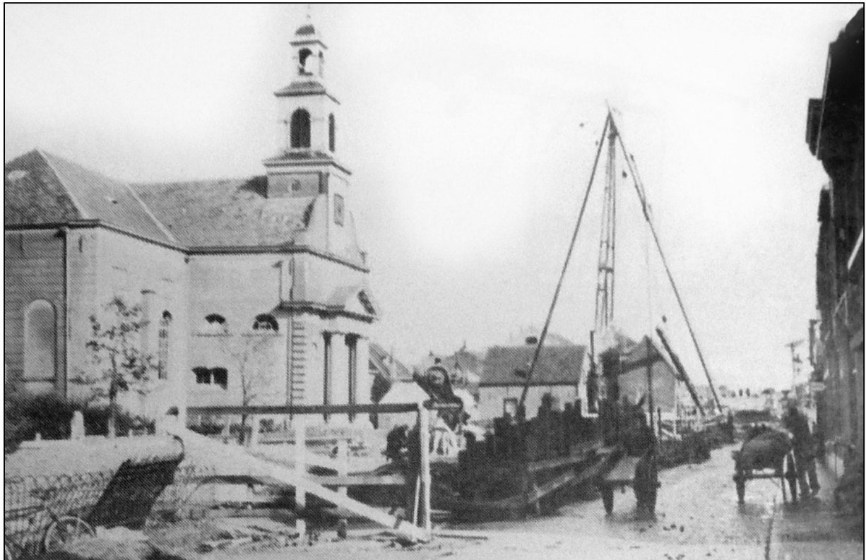
e. Bouw van de westelijke aanbrug in 1935, kijkende in oostelijke richting (bron: Versluis 1996).
