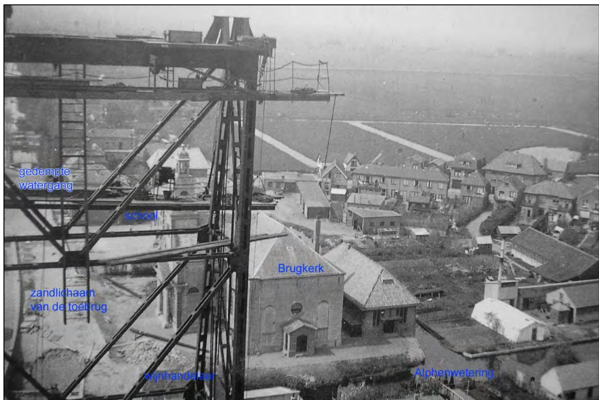
d. Overzicht vanaf de oostelijke brugtoren in 1935 of 1936, kijkende naar het westen (bron: Verlooi / Versluis 2002).
