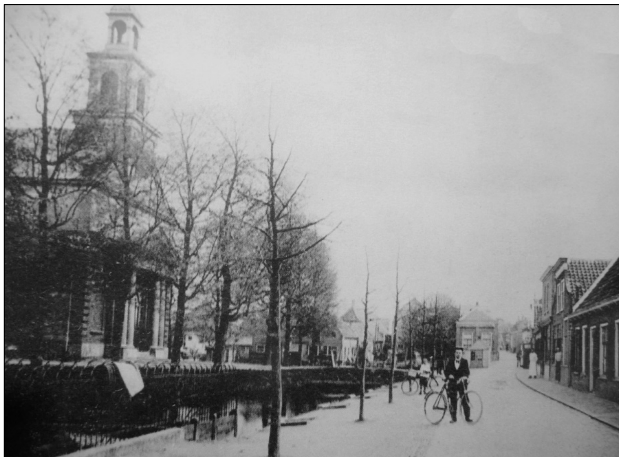
Figuur 13: Kerkweg-Oost met rechts de Brugkerk. Goed te zien is de brede watergang parallel aan de Kerkstraat-Oost. Foto uit circa 1910, kijkende in oostelijke richting (Verlooi / Versluis 2002).
