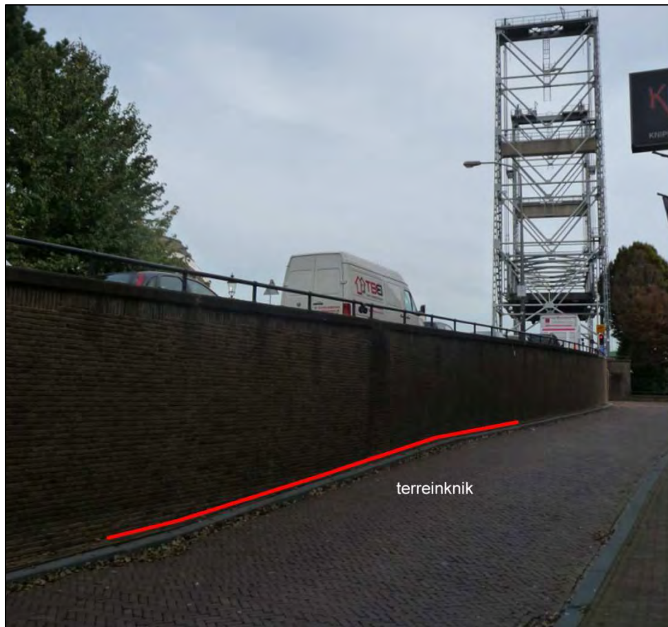
c. In het terrein duidelijk zichtbare terreinknik die de overgang. De zone langs de Gouwe ligt hoog.
