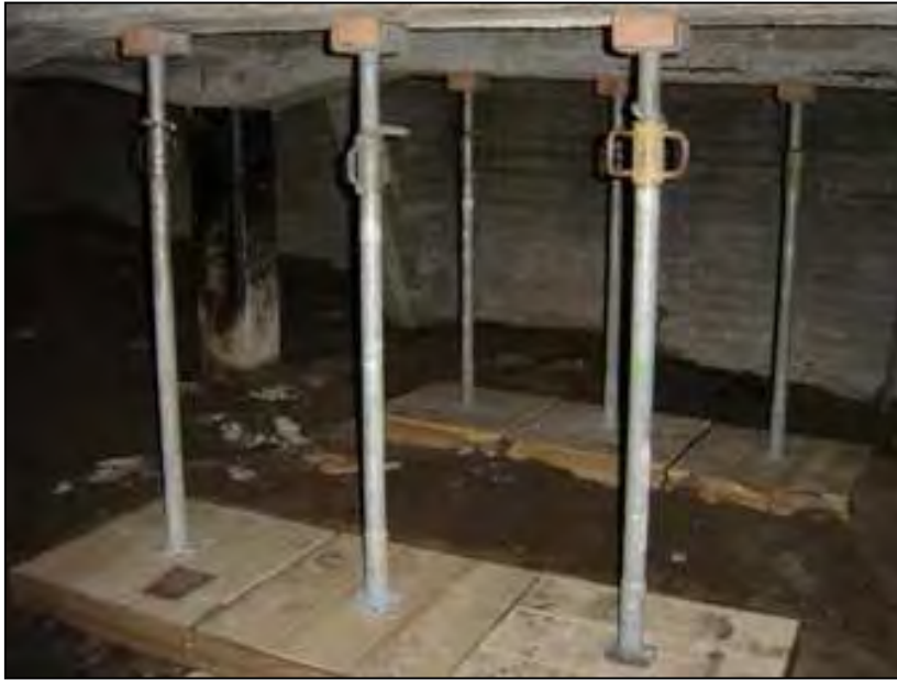
Figuur 7: De binnenzijde van de oprijdbrug van de Kerkweg-Oost. Deze wordt momenteel ondersteund om gebruik van normaal vrachtverkeer mogelijk te maken (bron: http://www.zuid-holland.nl ).
