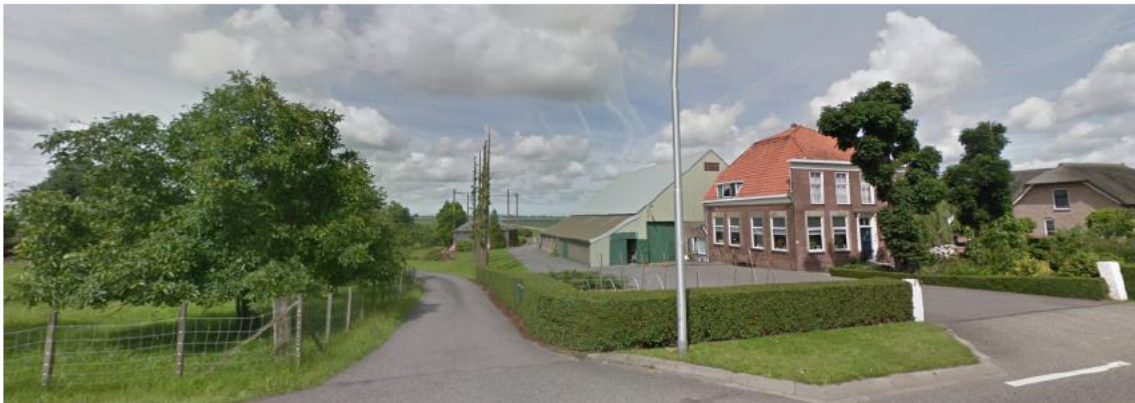
3. Boerderij met tuin, erf en bedrijfsloods aan de Noordeinde
