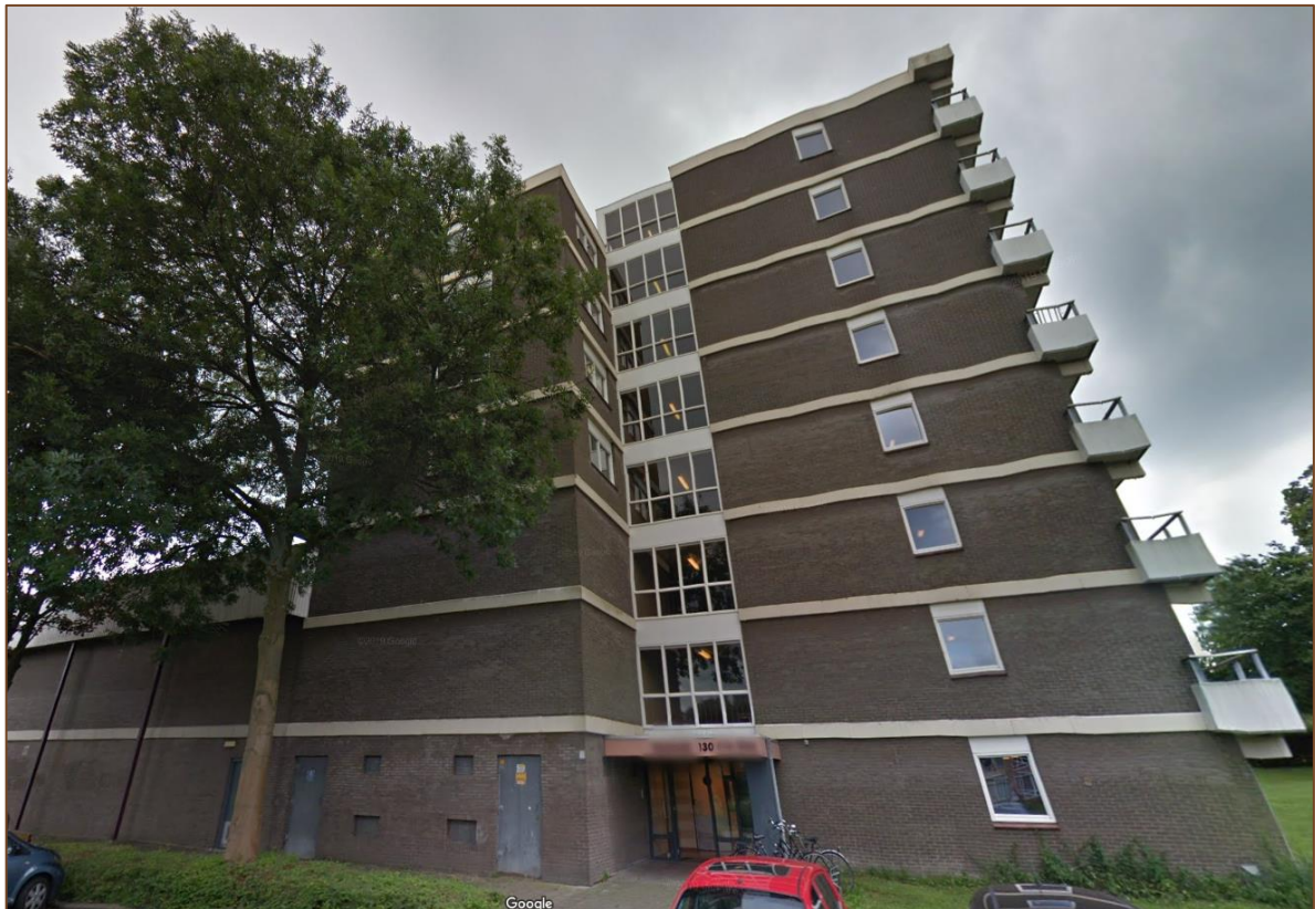
Foto 1. De zomerverblijfplaatsen van de gewone dwergvleermuis bevinden zich aan de onderzijde van de witte betonbanden (foto: google.com/maps ).
