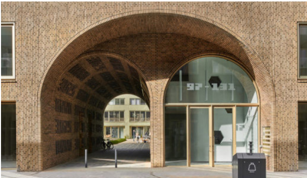
▲ Voorbeeld van een poortje door het gebouw, hier gecombineerd met entree naar de bovengelegen woningen.
