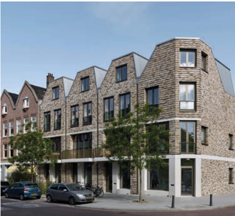
Rotterdam | hp architecten
