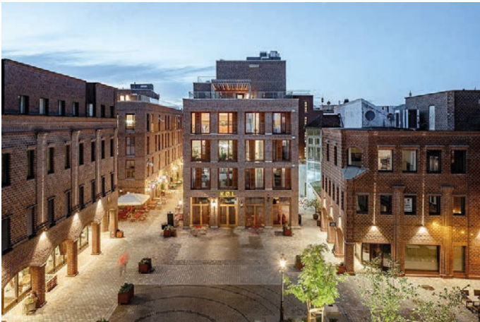
▲ Voorbeeld van een set gebouwen die gezamenlijk een pleintje afbakenen. Fredrikstad, Noorwegen - Mad Arkitekter
