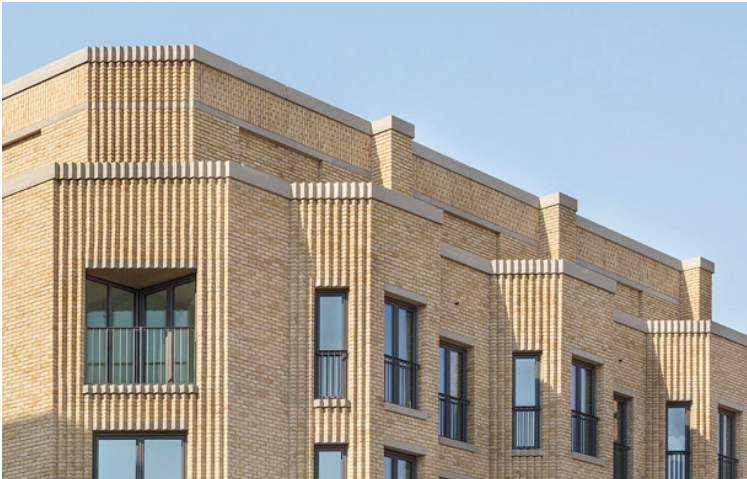
▲ Voorbeeld van het toevoegen van daklijst en kroon om installaties uit het straatbeeld te verbergen: Cadix Antwerpen | HCVA
