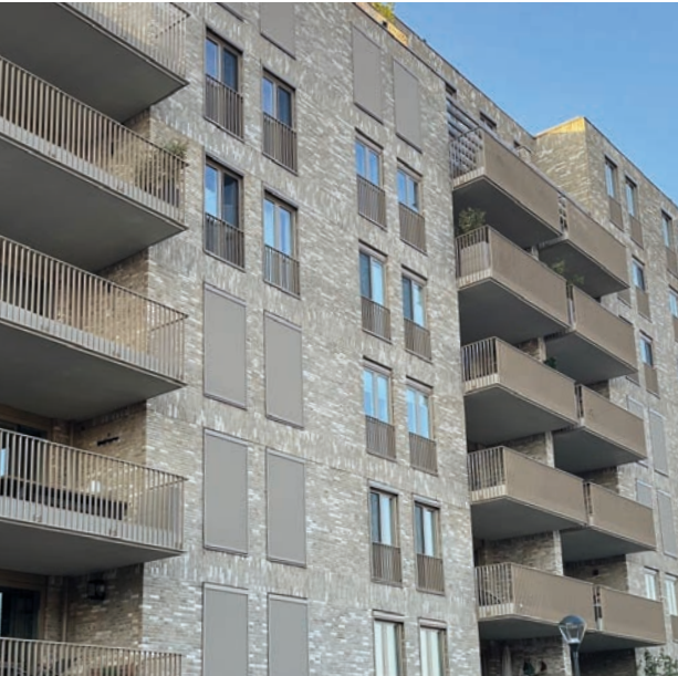
▲ Zonwering is geïntegreerd in het architectonisch ontwerp. Kozijnen en hekwerk zijn ton-sur-ton uitgevoerd.
