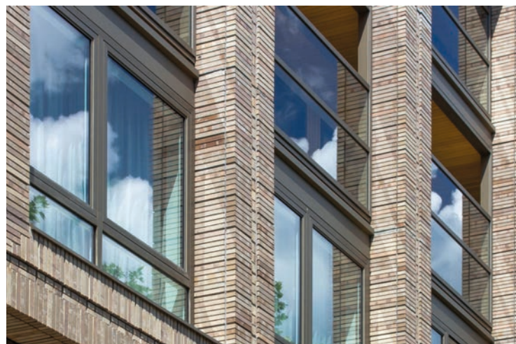
▲ Voorbeeld waar de galerij in het gevelbeeld verwerkt is. De diepe negges geven een hoogwaardige uitstraling. Kozijnen en raampartijen zijn integraal mee ontworpen in het beeld.
