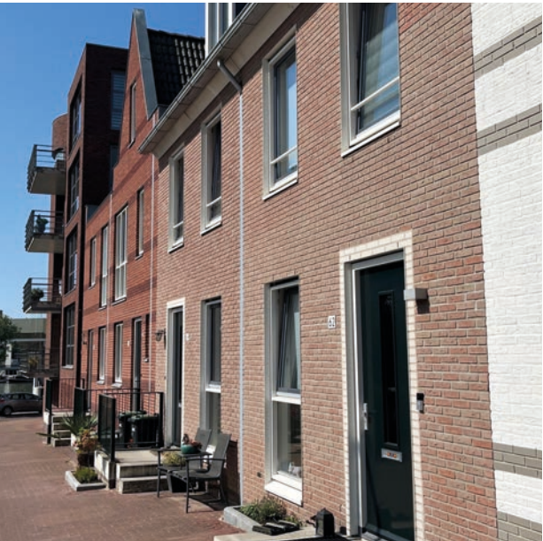
▲ Regenpijpen worden in de gevel geïntegreerd in plaats van daar tegenaan geplakt. Deze worden uitgevoerd in zink of vergelijkbare uitstraling.
